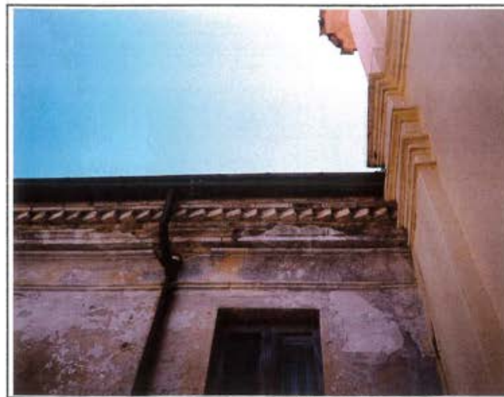
CORNICIONE Veduta prospettica
