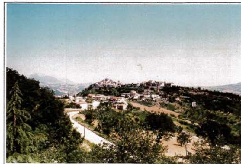
VEDUTA PANORAMICA LATO SUD
