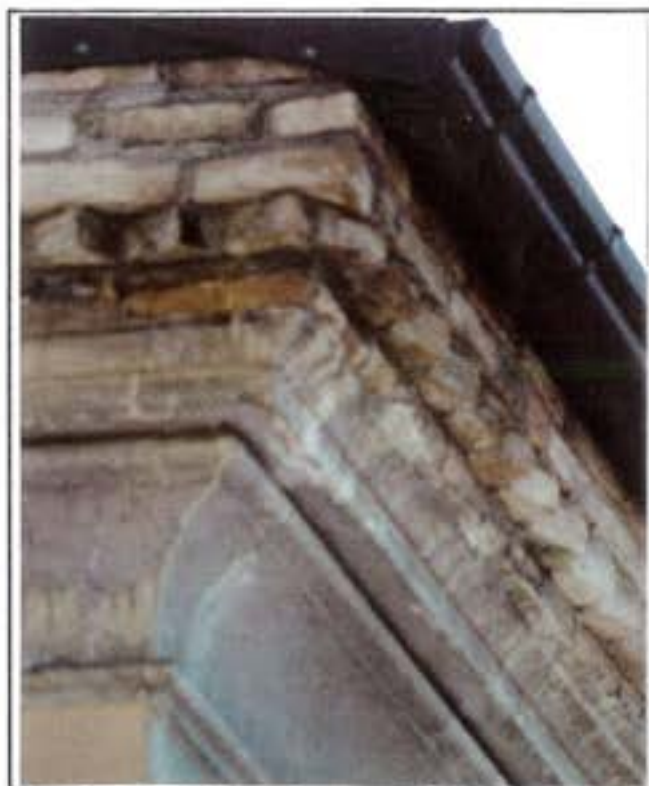
CORNICIONE Veduta prospettica
